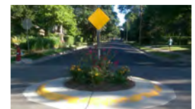
Mini roundabout at Holland Street
